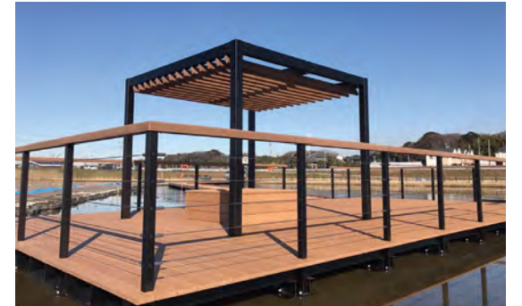
● 日本 | 千葉縣 | 国分川調整池緑地
